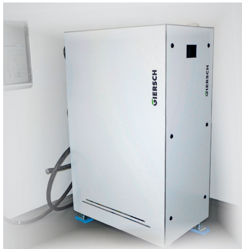
Marktreif: Hochtemperatur-Wärmepumpe (50 kW) von Giersch für Vorlauftemperaturen bis 90 °C. (Fotos: Genath)
