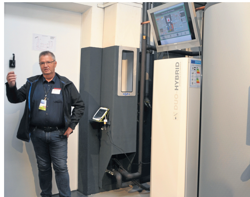
Vom Dach ging es in den Keller, wo ein weiteres Hybridsystem bestehend aus Brennwertheizung und Wärmepumpe erläutert wurde.
