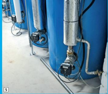
Die Thermoweiche entkoppelt die Wärmepumpen- und Gas-Kaskade hydraulisch. Dies sorgt für eine bessere Schichtung in den Speichern.
